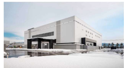
新潟・長岡データセンター外観
